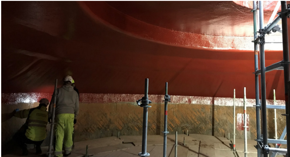
Fig. 2: Indvendig inspektion af Rådnetank 2 efter ny coating
