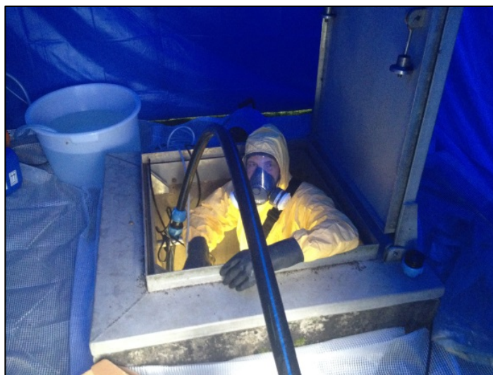
Foto 1 og 2. Fotos fra inspicering og desinficering af rentvandstanken på Dybendal Vandværk.
